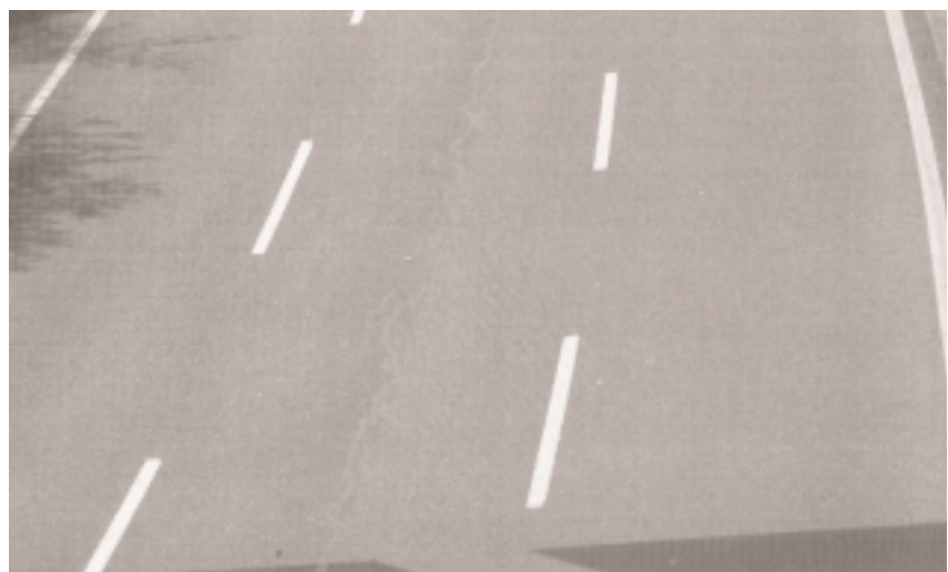
Zustand der Trinidad-Deckschicht (TA 16) nach 20jähriger Verkehrsbelastung auf der N1
