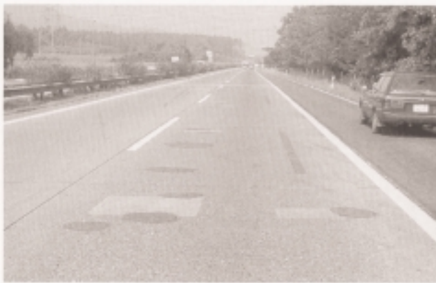
Nationalstraße N1 Rothrist-Baden, Schäden der Betondecke
