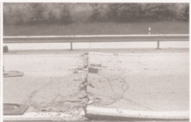
Nationalstraße N1 Rothrist-Baden, Schäden der Betondecke
