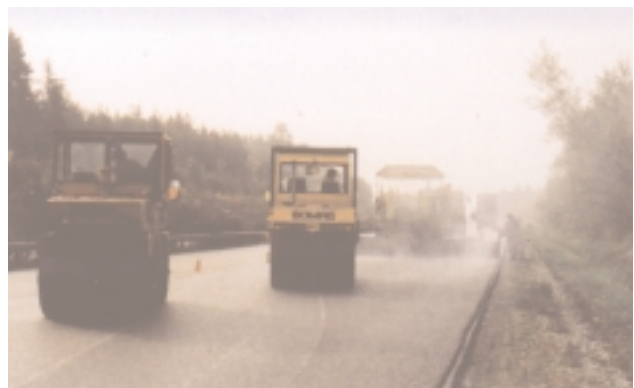
Bild 3: Einbau SMA 0/11 an der A2
