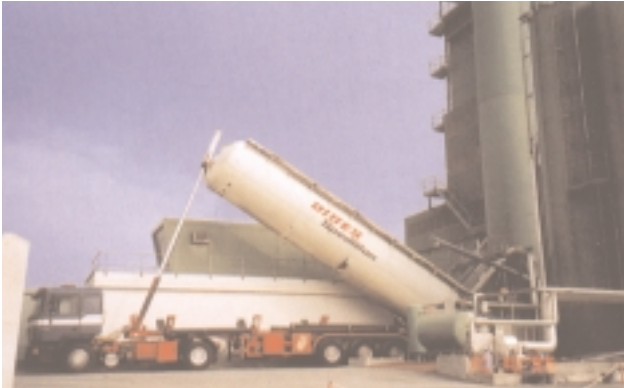
Bild 1 Anlieferung der NAF 501 Siloware
