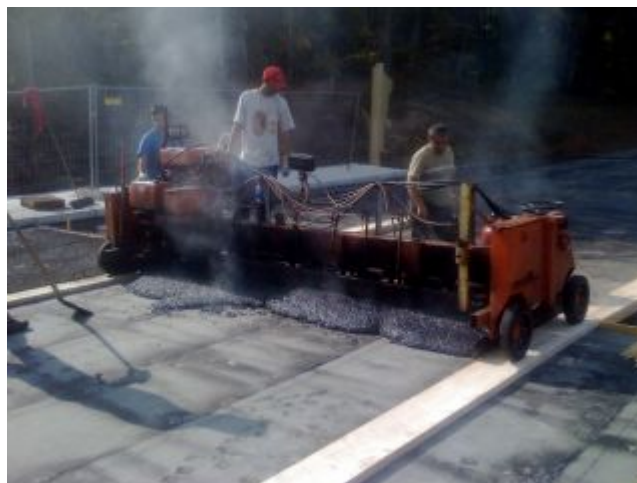
Einbau von Gussasphalt mit TE NV auf der BAB A 3 bei Würzburg
