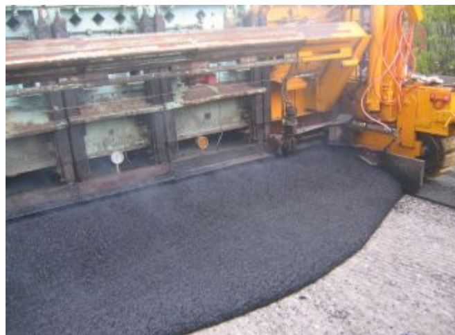
(„Schutzschicht“ aus Gussasphalt auf gefrästem Asphaltbinder als Unterlage für einen OPA-Belag; BAB 99 AD Feldmoching in Bayern)
