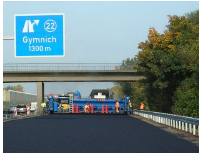
(lärmtechnisch optimierte Gussasphaltdeckschicht 0/8 S auf der BAB 61 in NRW)
