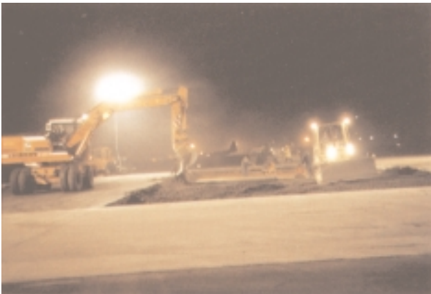
Einbau der Tragschicht
